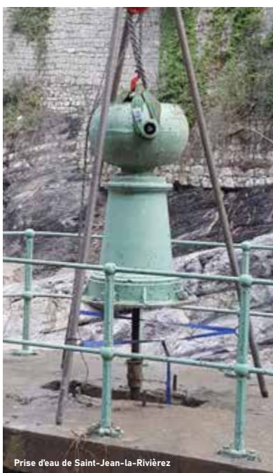
Prise d'eau de Saint-Jean-la-Rivière
