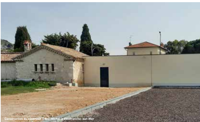
Construction du réservoir Saint-Michel à Villefranche-sur-Mer
