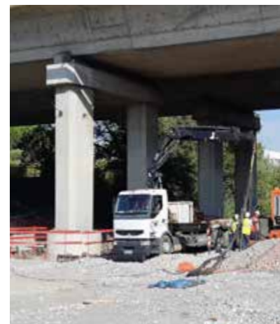
Mise à nu de la nappe du Var au pied d'une pile du viaduc de l'A8. Passage d'un hydrogéologue agréé et mise en place d'un grillage pour un minimum de protection, associées bien sûr à surveillance, fermeture sur les rives du chantier, surveillance de la qualité des eaux en plusieurs points.
