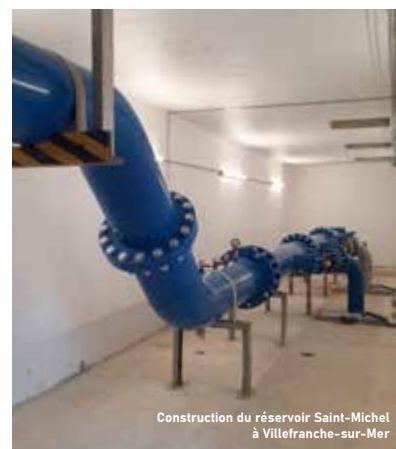
Construction du réservoir Saint-Michel à Villefranche-sur-Mer
