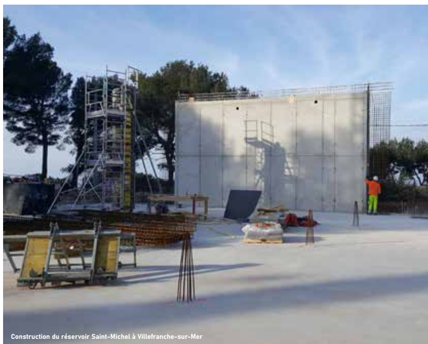
Construction du réservoir Saint-Michel à Villefranche-sur-Mer
