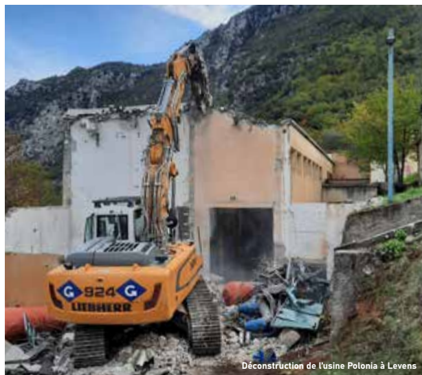
Déconstruction de l'usine Polonia à Levens
