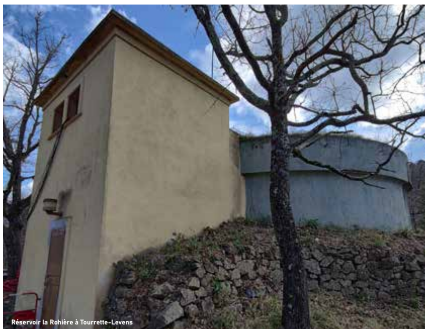
Réservoir la Rohière à Tourrette-Levens
