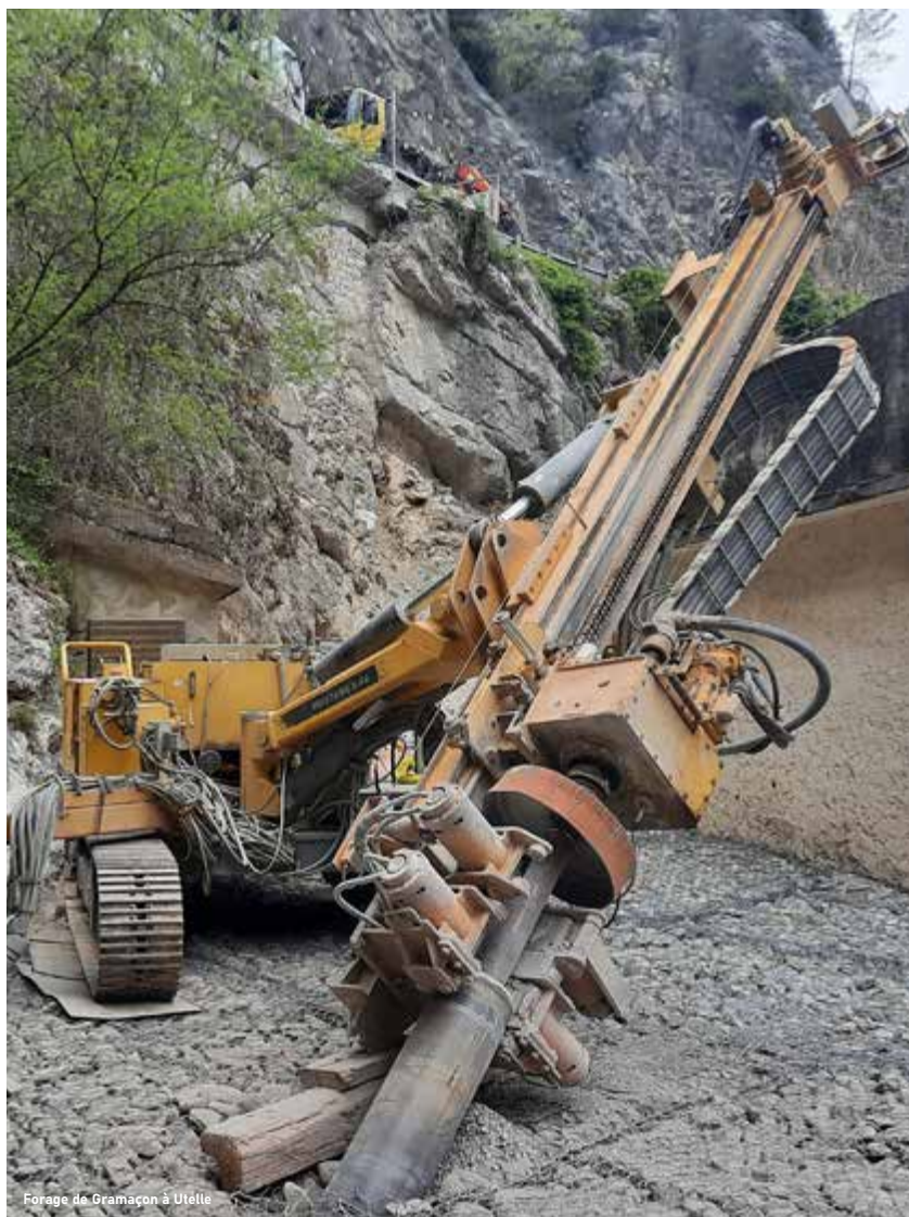
Forage de Gramaçon à Utelle
