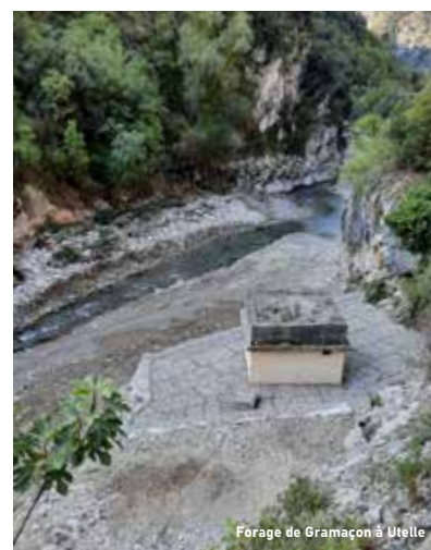
Forage de Gramaçon à Utelle
