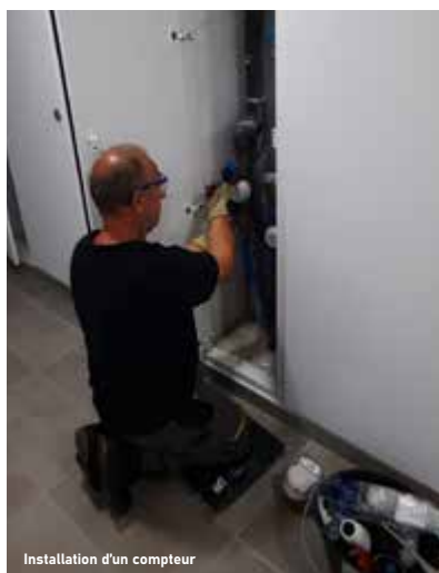
Installation d'un compteur
