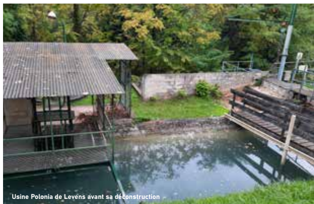
Usine Polonia de Levens avant sa déconstruction
