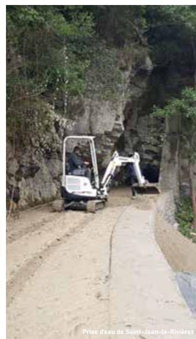
Prise d'eau de Saint-Jean-la-Rivière
