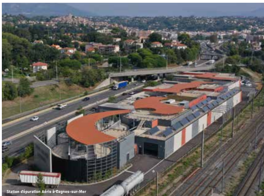
Station d'épuration Aëris à Cagnes-sur-Mer
