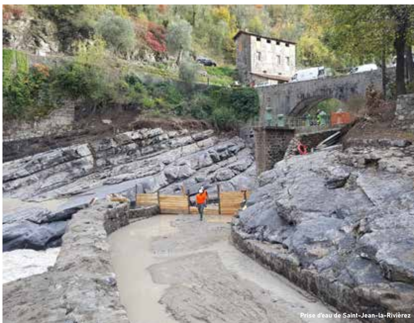
Prise d'eau de Saint-Jean-la-Rivière
