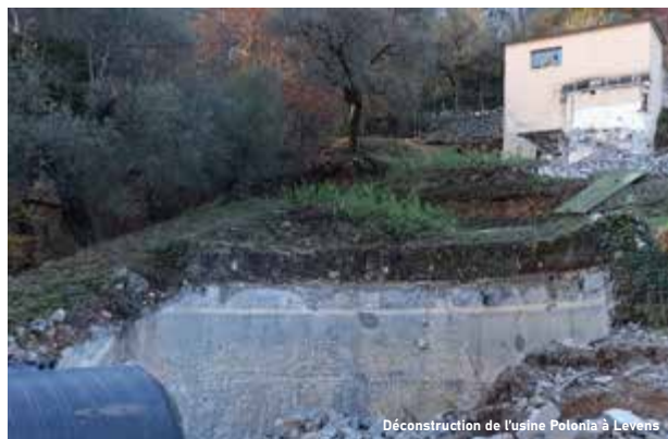
Déconstruction de l'usine Polonia à Levens
