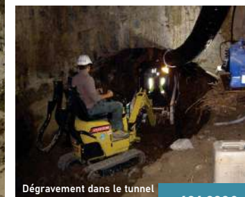
Dégagement dans le tunnel
