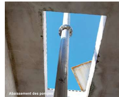
Abaissement des pompes
