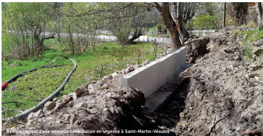
Remplacement d'une nouvelle canalisation en urgence à Saint-Martin-Vésubie
