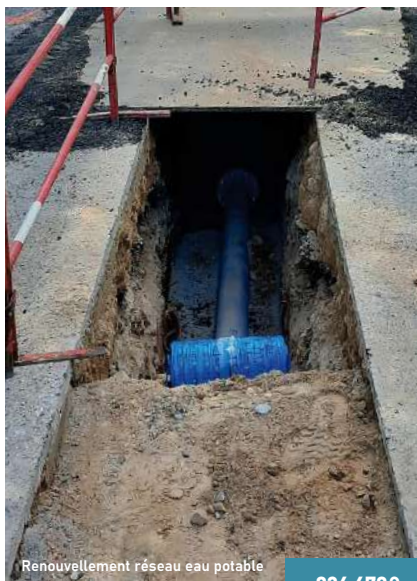
Renouvellement réseau eau potable
