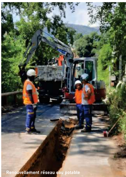
Renouvellement réseau eau potable
