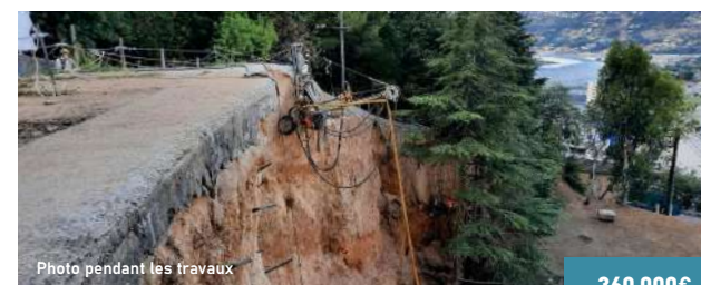
Photo pendant les travaux
