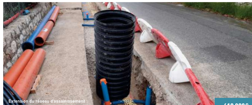
Extension du réseau d'assainissement
