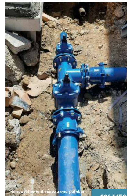
Renouvellement réseau eau potable
