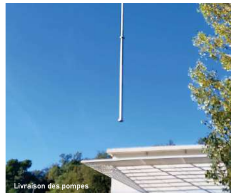
Livraison des pompes
