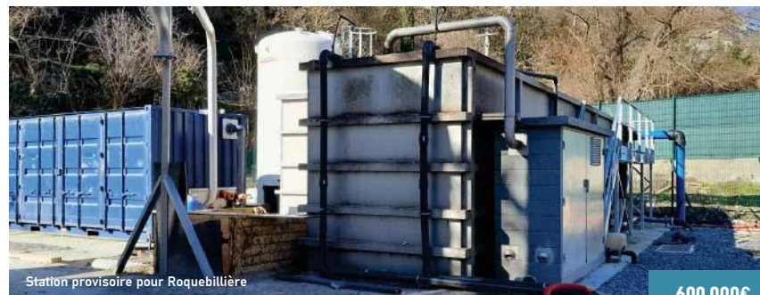
Station provisoire pour Roquebillière
