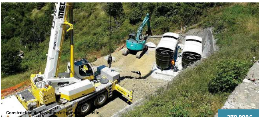
Construction de la station d'épuration d'Utelle
