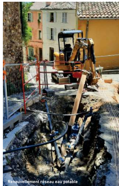
Renouvellement réseau eau potable
