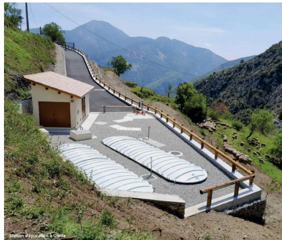
Station d'épuration à Utelle
