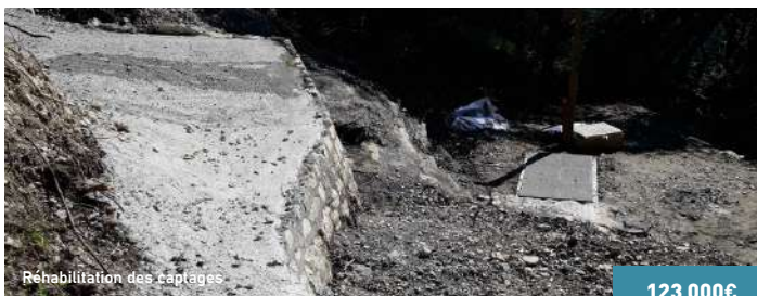
Réhabilitation des captages
