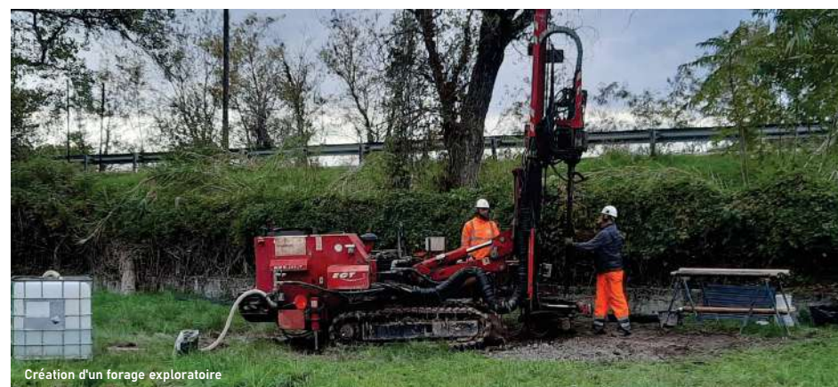
Création d'un forage exploratoire
