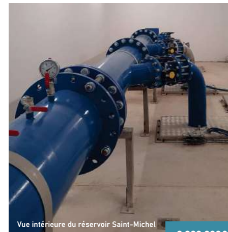
Vue intérieure du réservoir Saint-Michel
