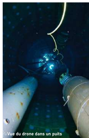
Vue du drone dans un puits
