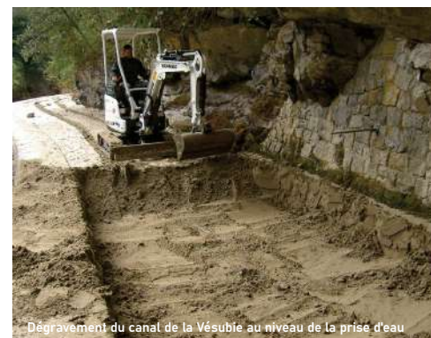
Dégagement du canal de la Vésubie au niveau de la prise d'eau
