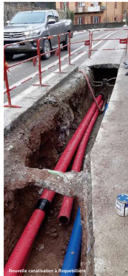
Nouvelle canalisation à Roquebillière
