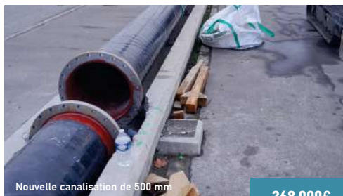
Nouvelle canalisation de 500 mm
