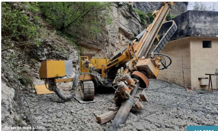
Forage en cours à Utelle
