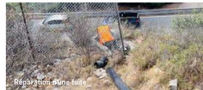
Réparation d'une fuite
