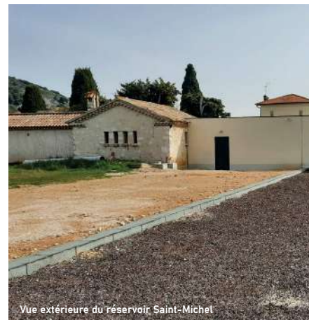
Vue extérieure du réservoir Saint-Michel
