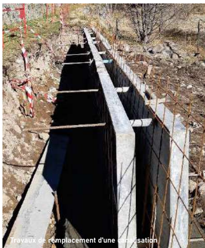
Travaux de remplacement d'une canalisation
